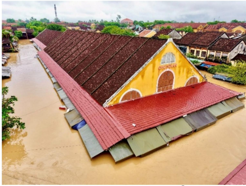
Gia Hộ nước cao gần sát mái
